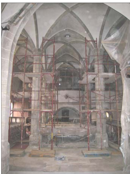
Die Renovierung der Säulen war eine sehr heikle Angelegenheit.
