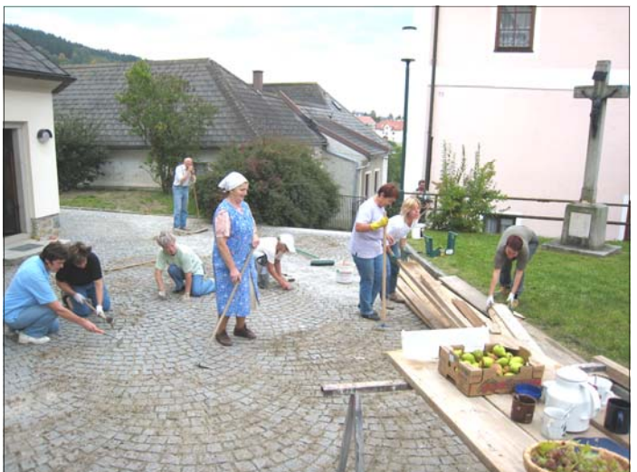
Auch vor der Kirche wird eifrig geputzt und das Pflaster gereinigt.
