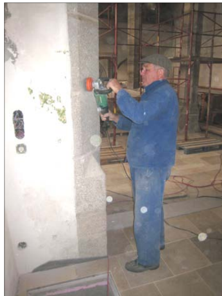
Jede Säule wird abgeschliffen und gereinigt.
