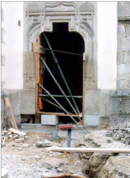
Das Eingangsportal wird abgesenkt und somit barrierefrei.
